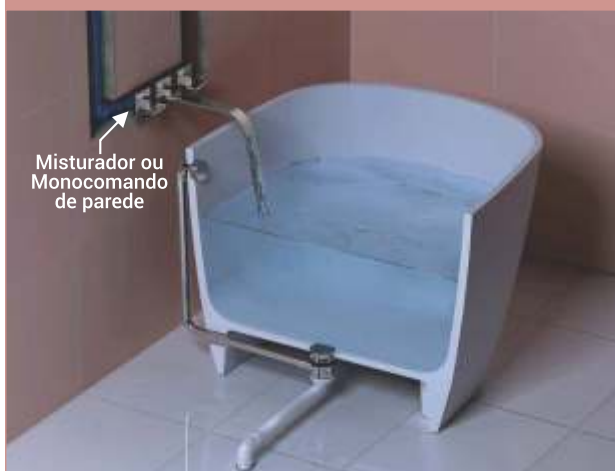
Opção 3: Misturador ou monocomando instalado na parede
