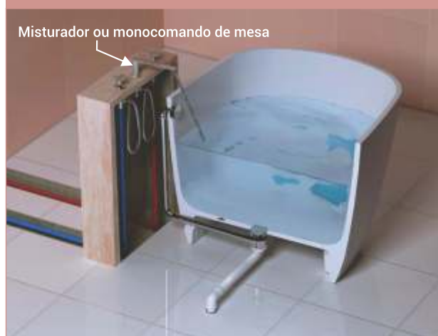
Opção 4: Monocomando de mesa instalado na mureta
