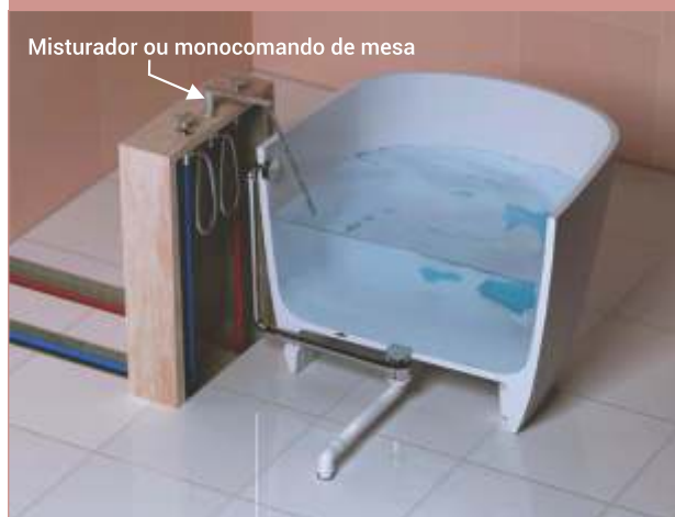
Opção 4: Monocomando de mesa instalado na mureta
