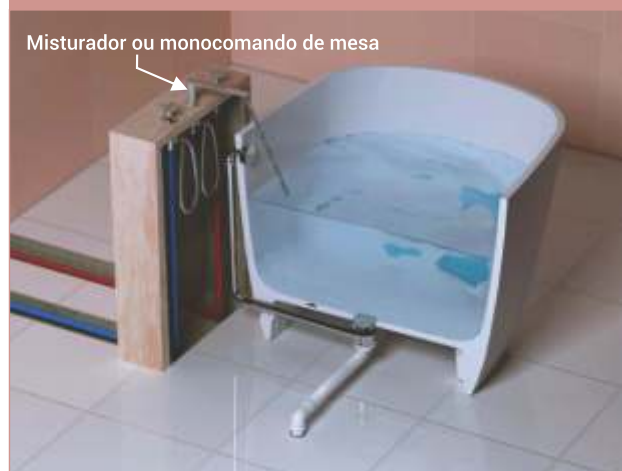
Opção 4: Monocomando de mesa instalado na mureta
