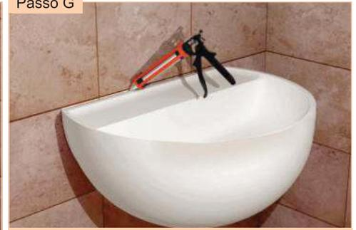
Por fim, **aplique silicone** entre o lavatório e a parede.
