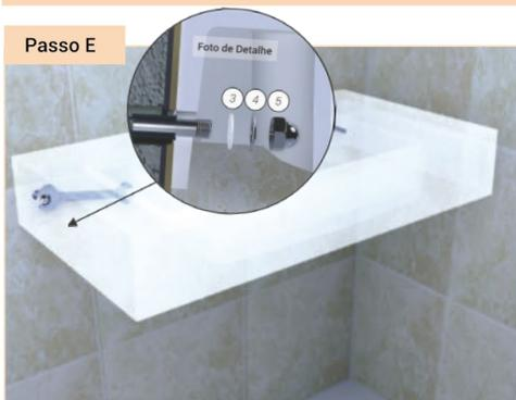
**Encaixe o lavatório nos parafusos** fixos na parede **e insira a arruela plástica** (item 3), **arruela lisa** (item 4) **e a porca para parafuso** (item 5) do seu kit, conforme foto de detalhe. **Aperte a porca** (item 5) com uma chave de boca 13 mm e deixe uma leve folga.
