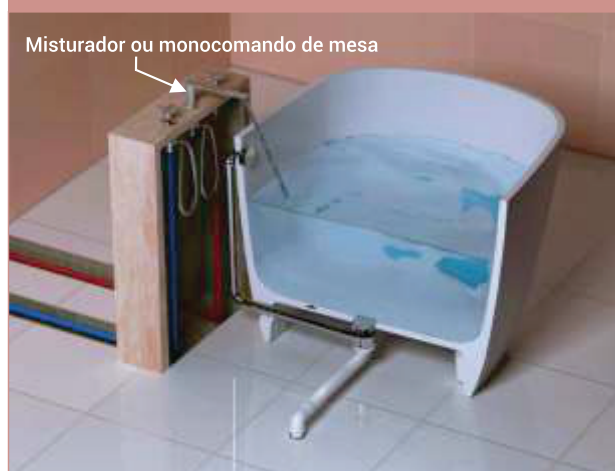
Opção 4: Monocomando de mesa instalado na mureta
