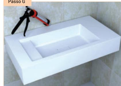
Por fim, **aplique silicone** entre o lavatório e a parede.
