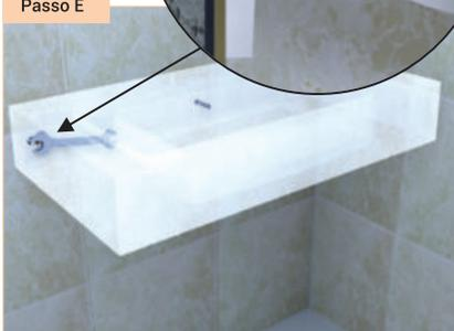
**Encaixe o lavatório nos parafusos** fixos na parede e **insira a arruela plástica** (item 3), **arruela lisa** (item 4) e **a porca para parafuso** (item 5) do seu kit, conforme foto de detalhe. **Aperte a porca** (item 5) com uma chave de boca 13 mm e deixe uma leve folga.
