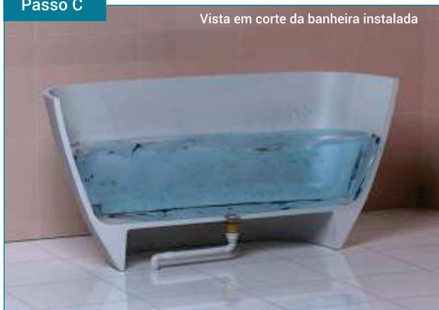
Retorne a banheira à posição original e encha de água para testar se ocorrem vazamentos.
